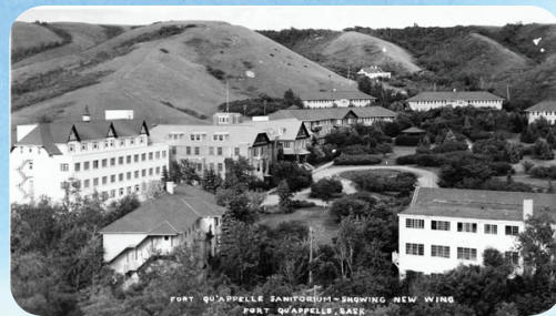
Fort Qu'Appelle Sanatorium - showing new wing. Fort Qu'Appelle, Sk, ca. 1927, Saskatoon Library, PH-2006-84
